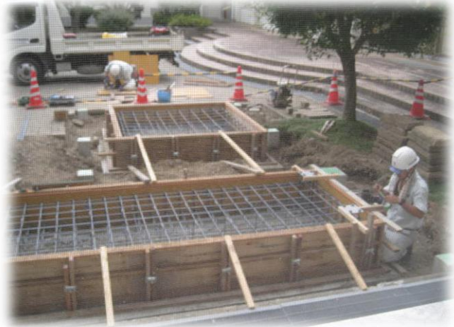
【エアコンの室外機やガスタンクが設置される場所】
