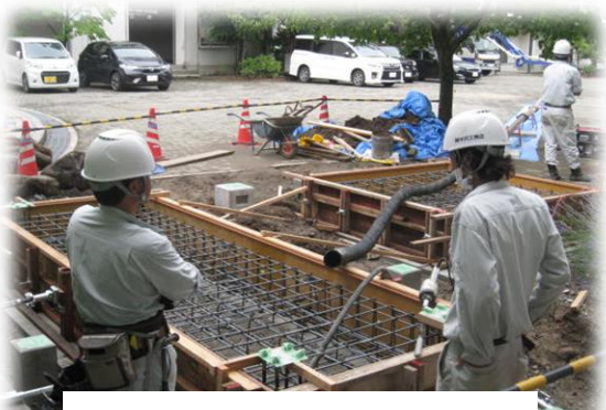
【コンクリートを流し込み、土台が完成】
